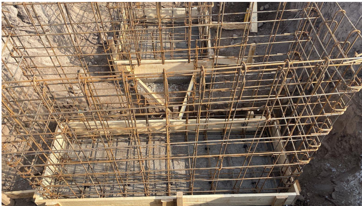
Emplazamiento de enfierraduras.
