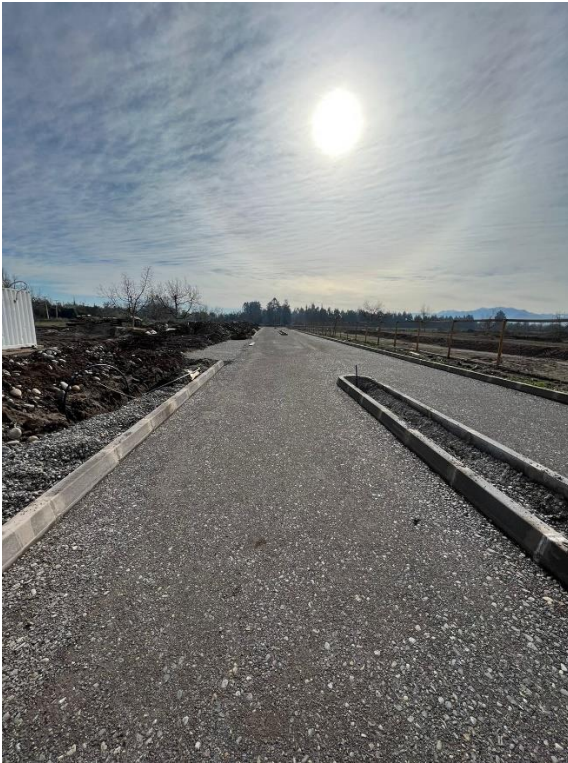
Calle 2 con base compactada lista para la recepción de la carpeta asfáltica.
