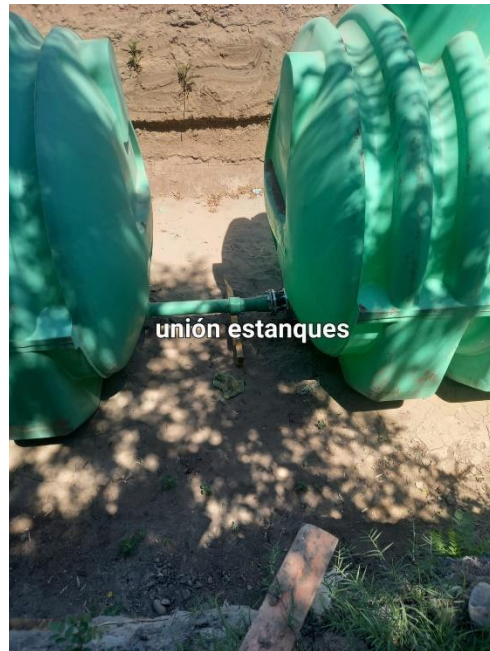
Uniones de estanques de acumulación.
