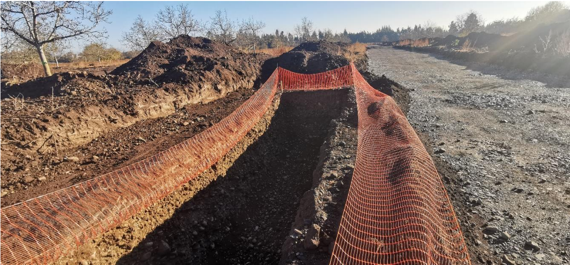
Calle N°2 - Mejoramiento Integral Compactado. Vista hacia el Norte.
