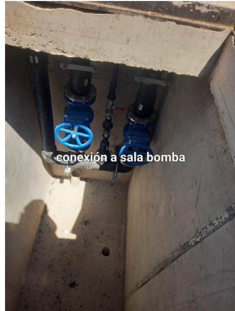
Equipamiento de sala de bombas para sistema de riego.
