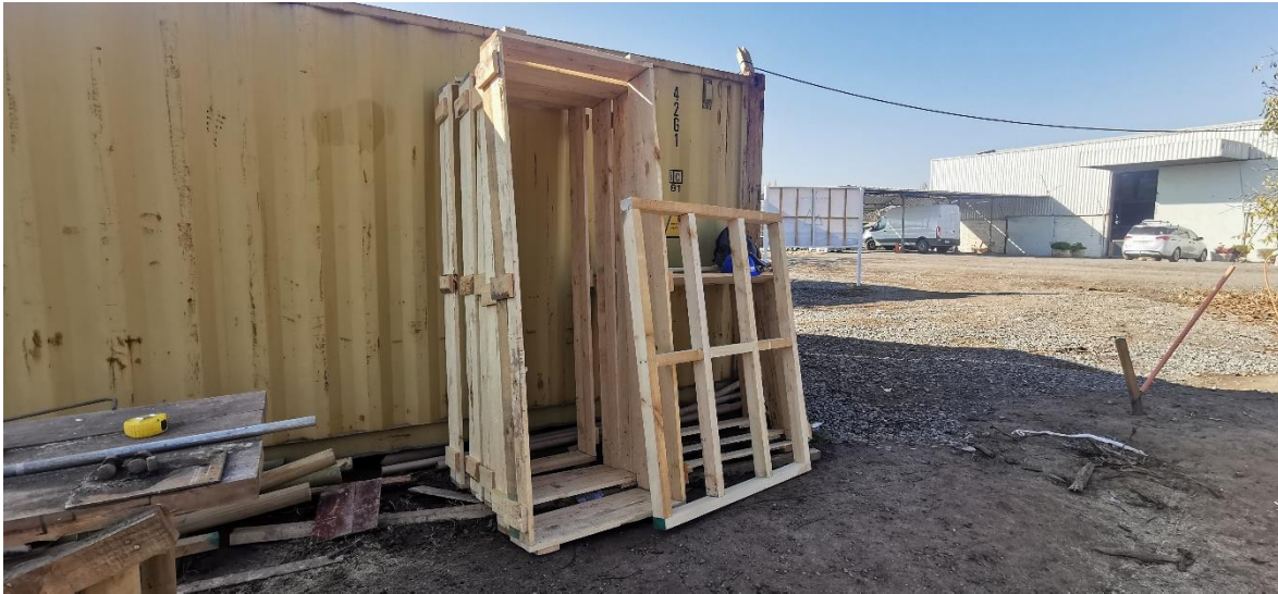
Confección de moldajes para losas.
