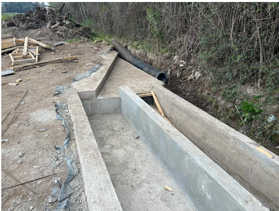
Restauración del canal para la captación del agua de riego.
