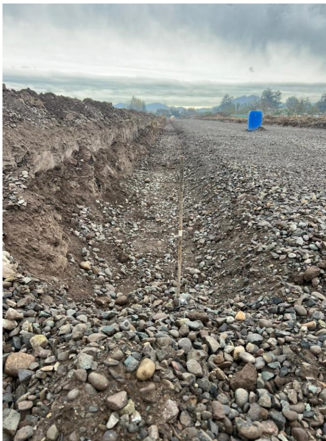
Preparación de cancha para instalación de soleras.
