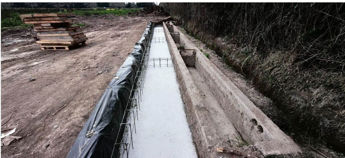
Confección de segundo canal de decantación para aguas de riego.
