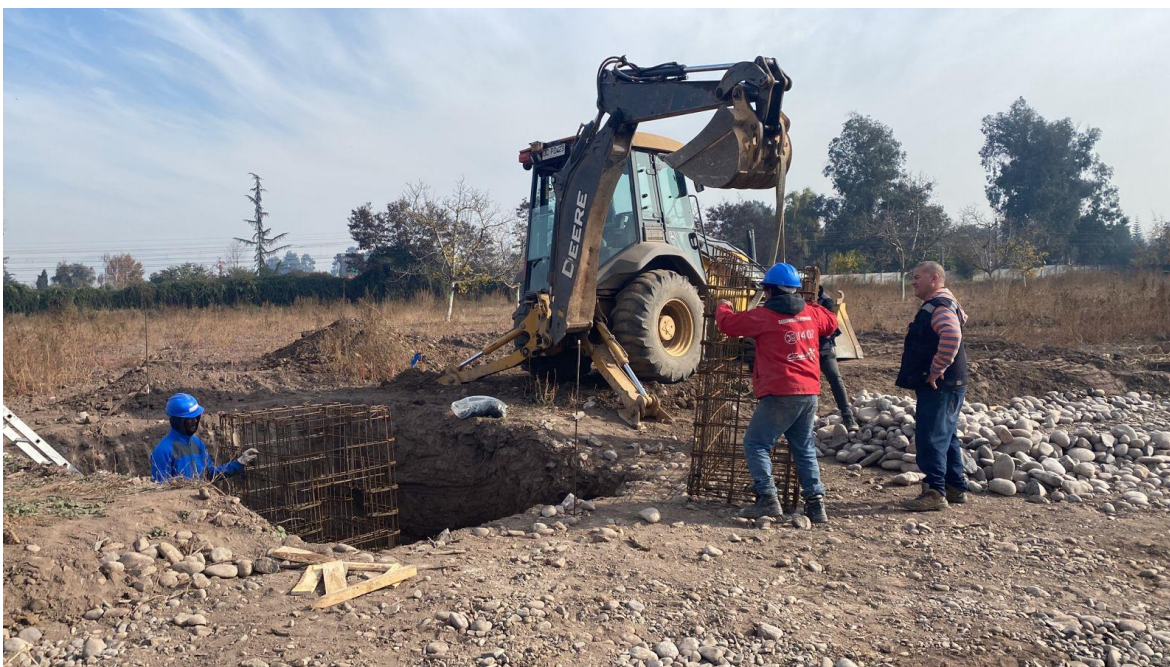
Instalación de enfierraduras. (Resumideros y cámaras)
