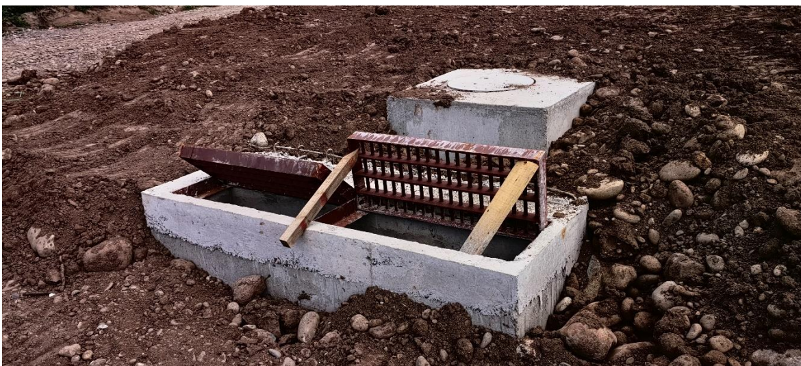
Hormigonado de rejillas e instalación de tapa hormigonada en decantador.
