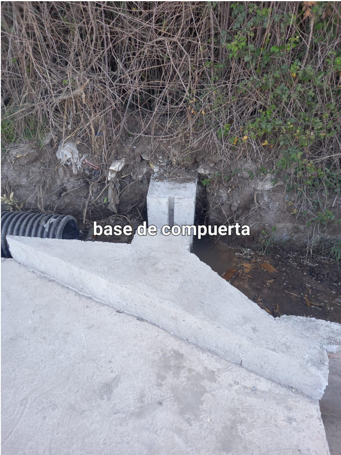
Estructura de soporte para compuerta de canal existente.
