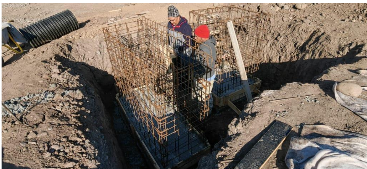
Hormigonado de radieres. (Resumideros y cámaras)
