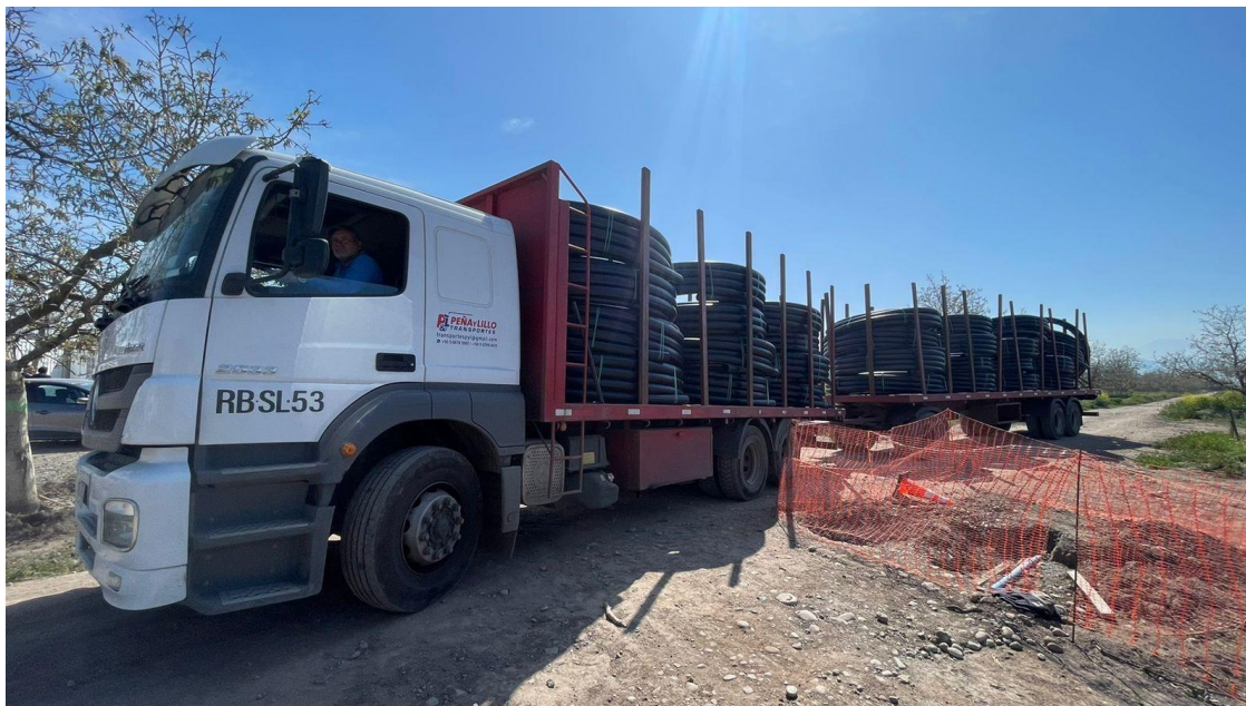
Tuberías HDPE para comenzar con los trabajos de matricería de riego
