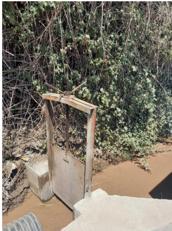
Termino de compuerta en canal para captación de agua de riego.
