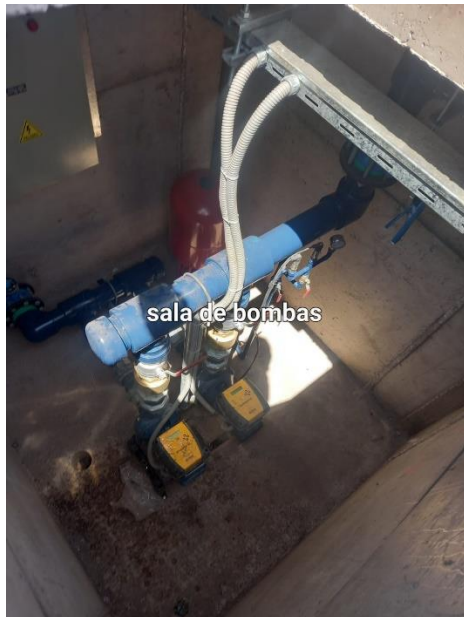
Equipamiento de sala de bombas para sistema de riego.
