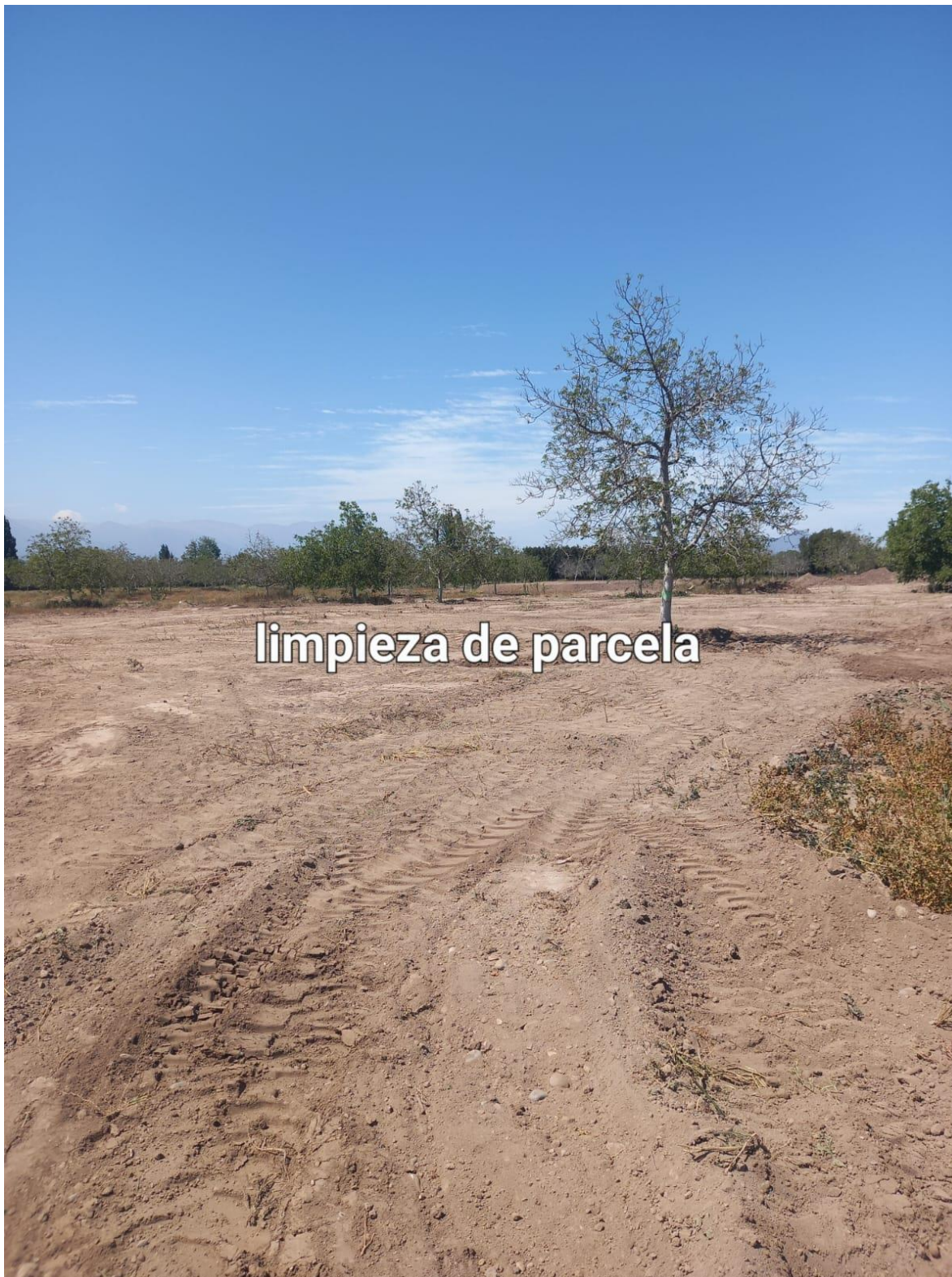
Despeje de terreno
