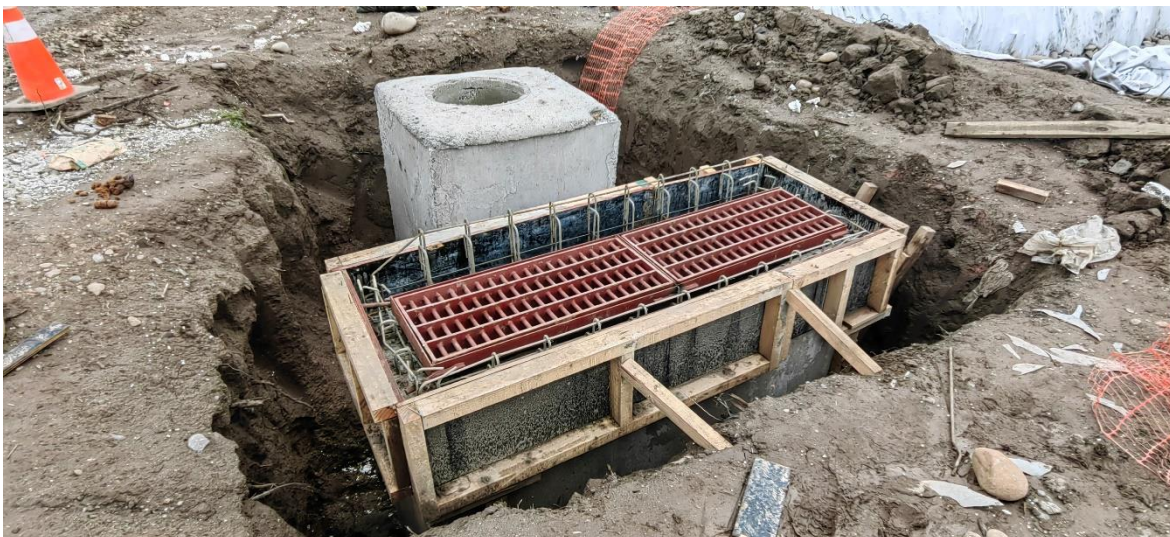
Instalación y hormigonado de rejillas de registro y manutención.
