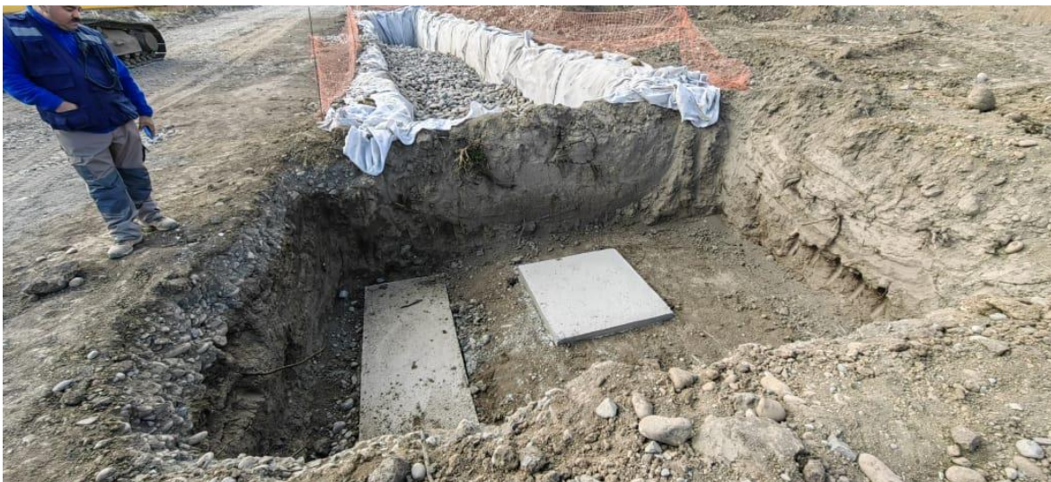
Retiro de moldajes. Fraguado y emplazamiento de radieres.
