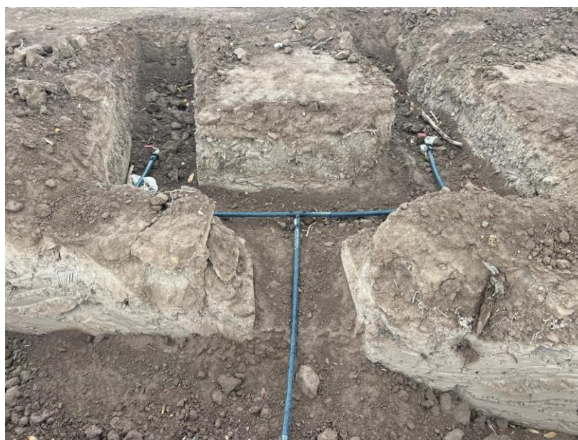
Instalación de arranques de riego en acceso de parcelas.
