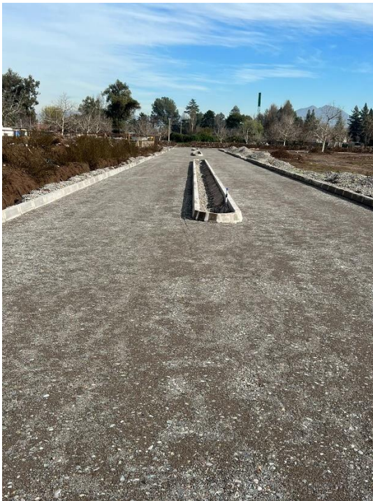
Calle con base compactada lista para la recepción de la carpeta asfáltica.
