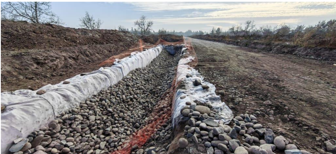
Llenado de bolones hasta nivel de instalación de ductos.
