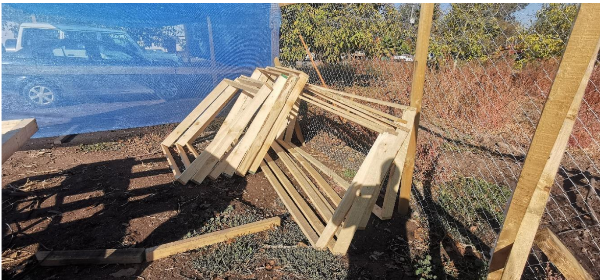
Confección de moldajes para emplantillados.
