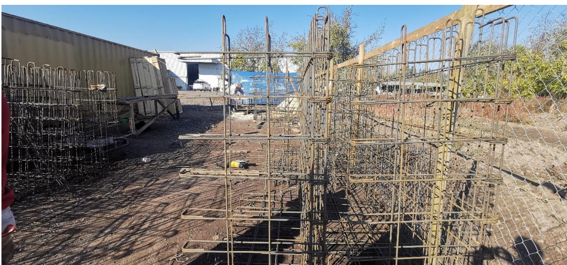
Confección de enfierraduras para cámaras sumidero de hormigón armado.
