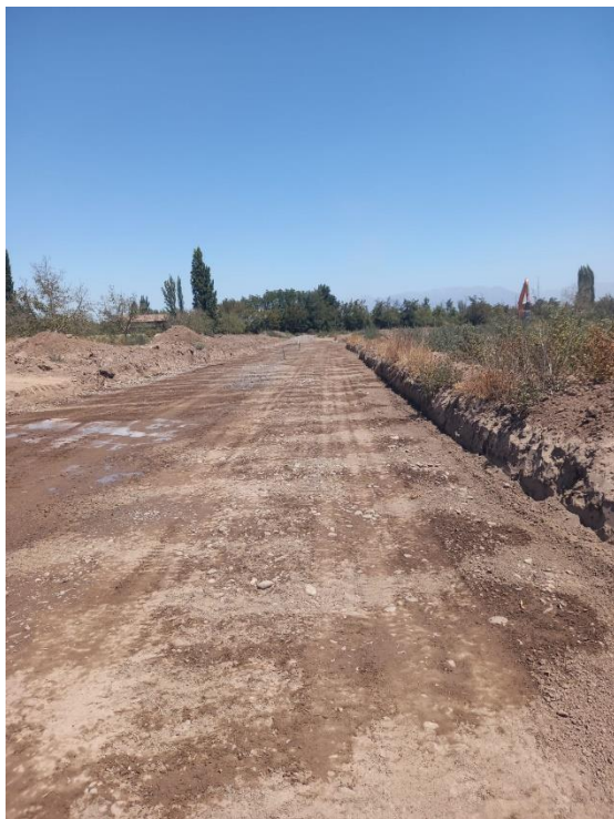
Preparacion de subrasante previo a la colocacion de base estabilizada.
