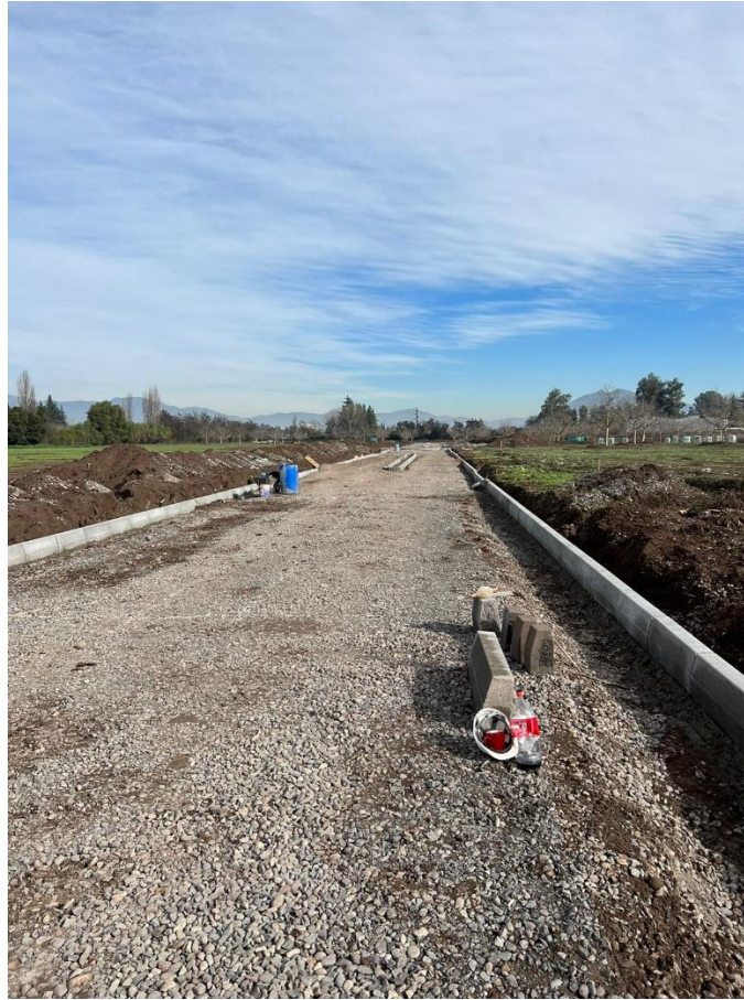
Termino de instalación de soleras tipo A en calle 4.
