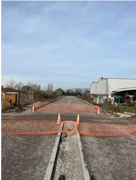
Calle 2 con base compactada lista para la recepción de la carpeta asfáltica.
