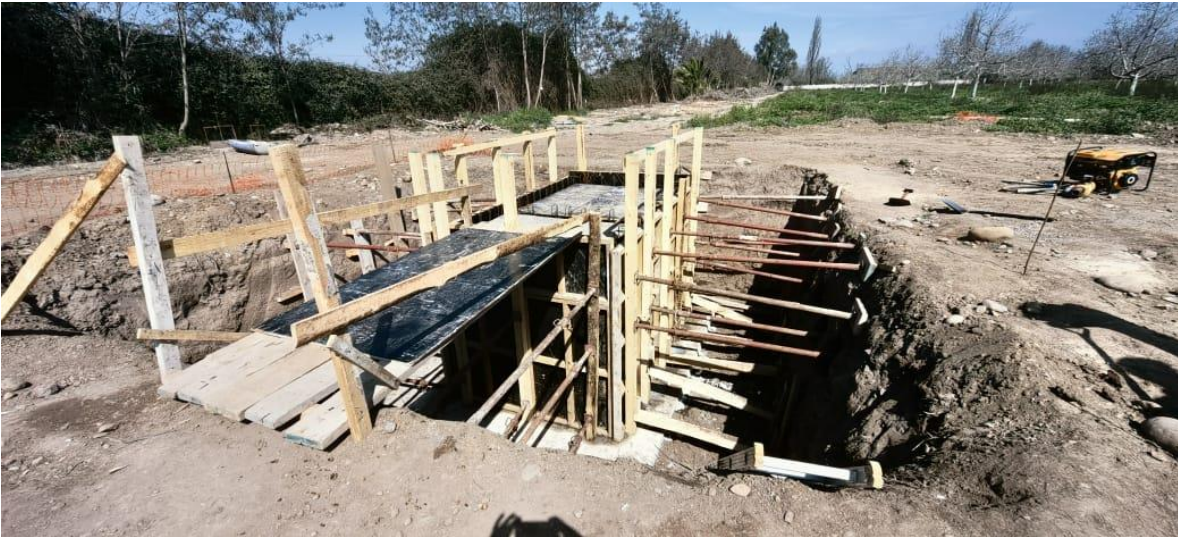
Confección de moldajes para hormigonado de sala de máquinas subterránea para sistema de riego.
