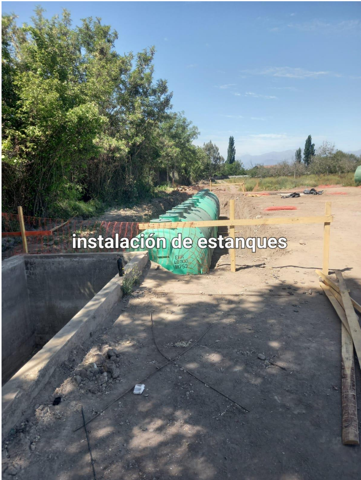
Posicionamiento de estanques de sistema de riego.
