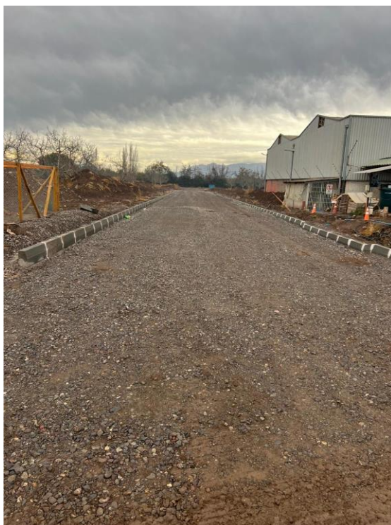
Instalacion de soleras laterales y en bandejones centrales.
