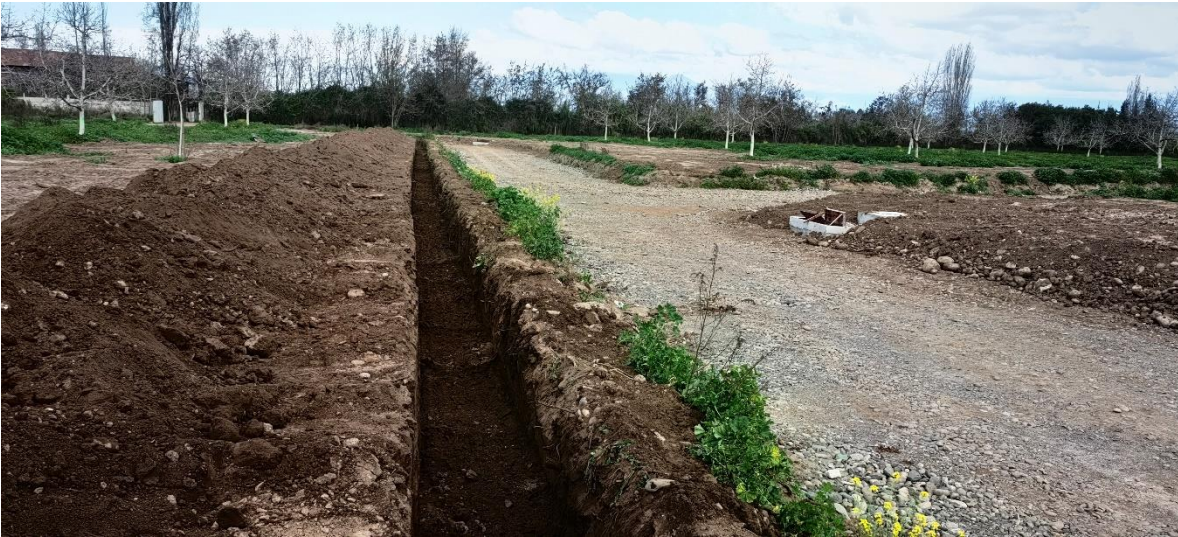
Excavación perimetral para instalación de matrices de aguas de riego y agua potable en Calle 1.
