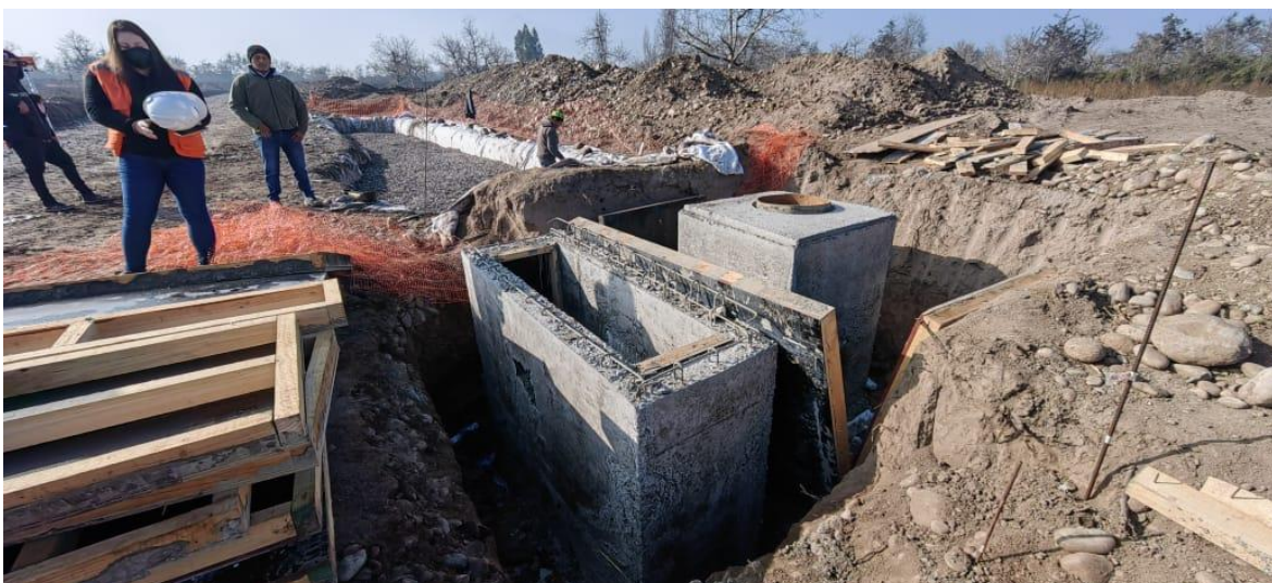
Hormigonado (obra gruesa) de resumideros y cámaras.
