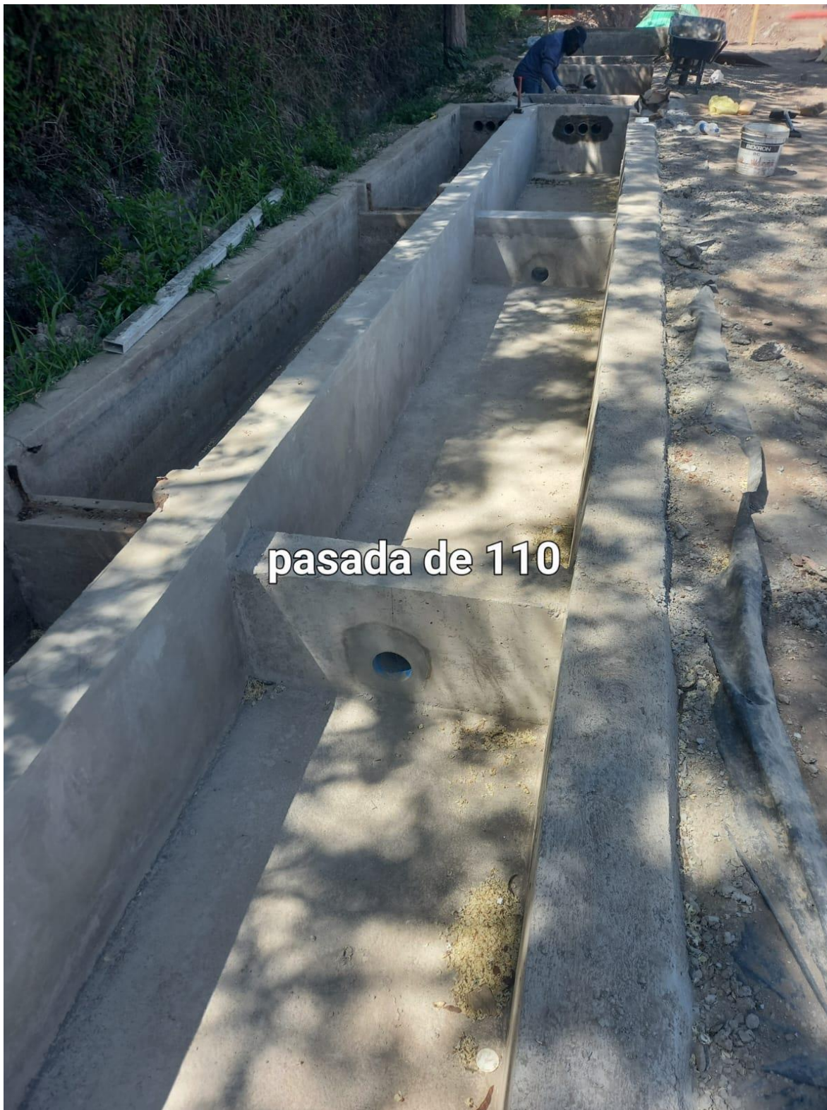
Pasadas terminadas en canal de decantación
