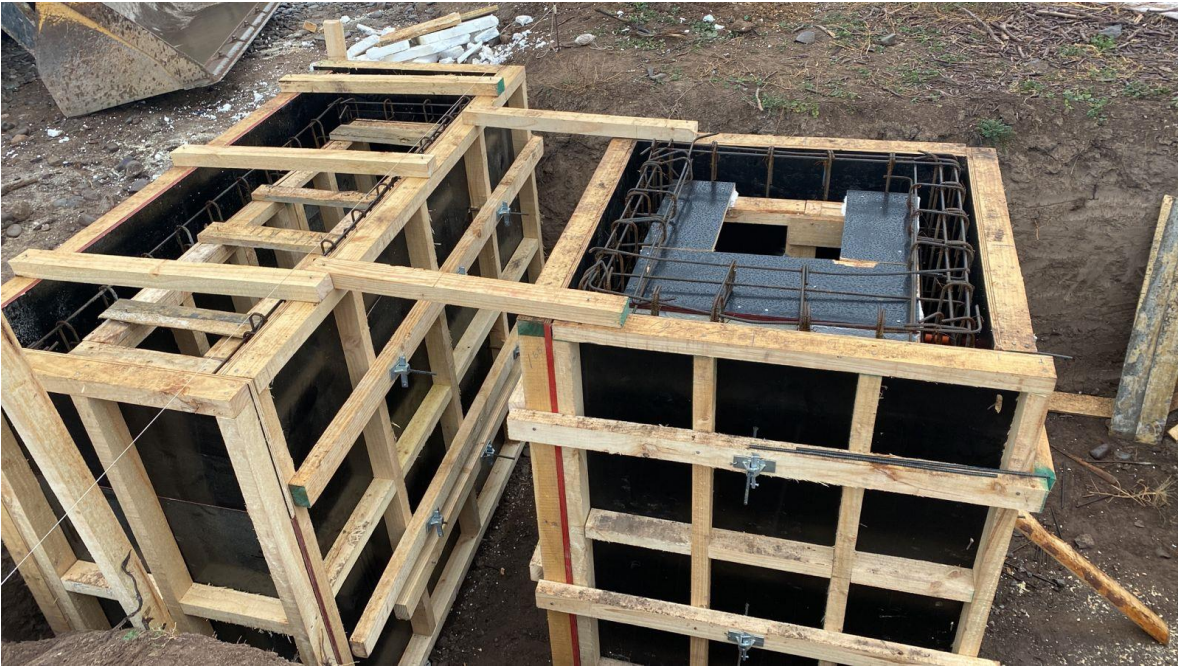
Instalación de Moldajes para hormigonado de resumideros y cámaras.
