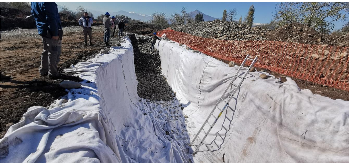
Colocación de manto geotextil y comienzo de relleno en base a bolones según ingeniería.
