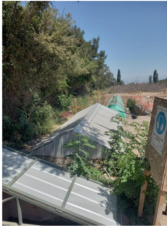
Termino de techumbre de sistema de decantación para riego.
