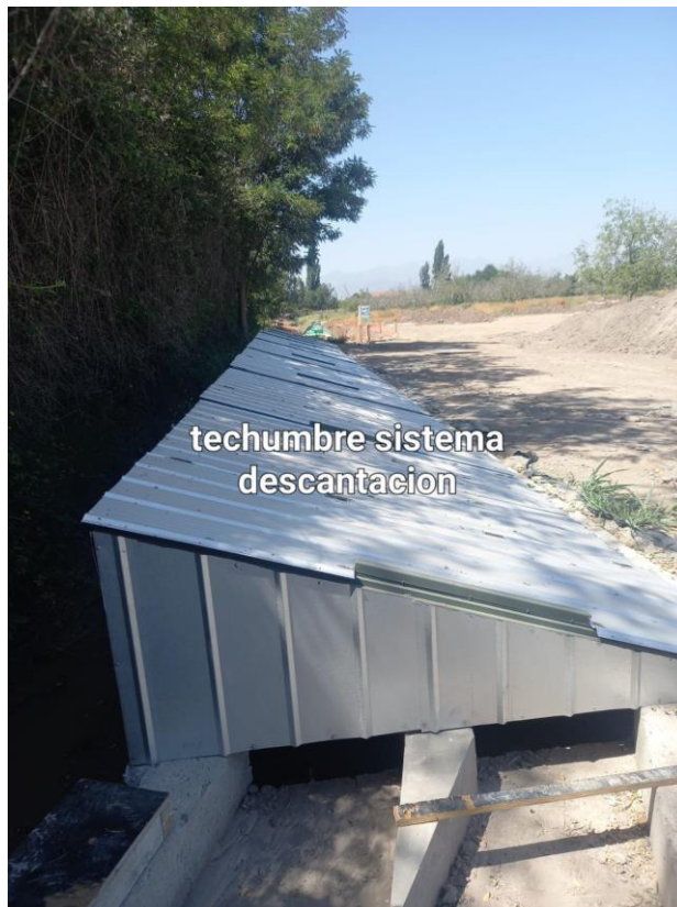
Techumbre sistema de decantación de agua de riego.
