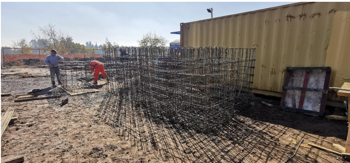
Confección de enfierraduras para cámaras de decantación de hormigón armado.
