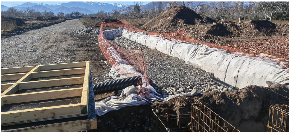
Colocación de grava y gravilla en drenes sobre ductos HDPE.
