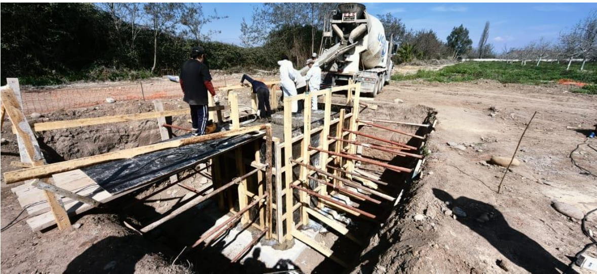
Hormigonado de sala de máquinas subterránea para sistema de riego, con incorporación de aditivo hidrófugo y acelerante de fragüe.
