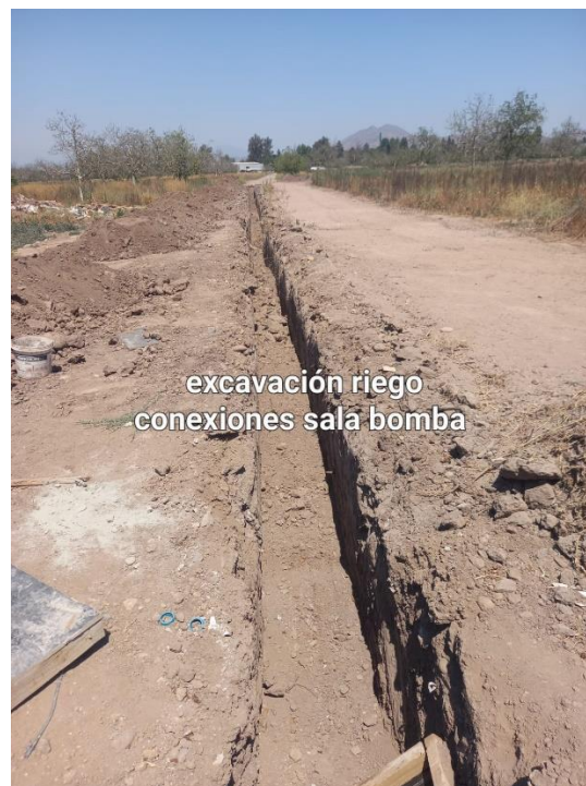
Zanja para conectar matricería de riego a sala de bombas.
