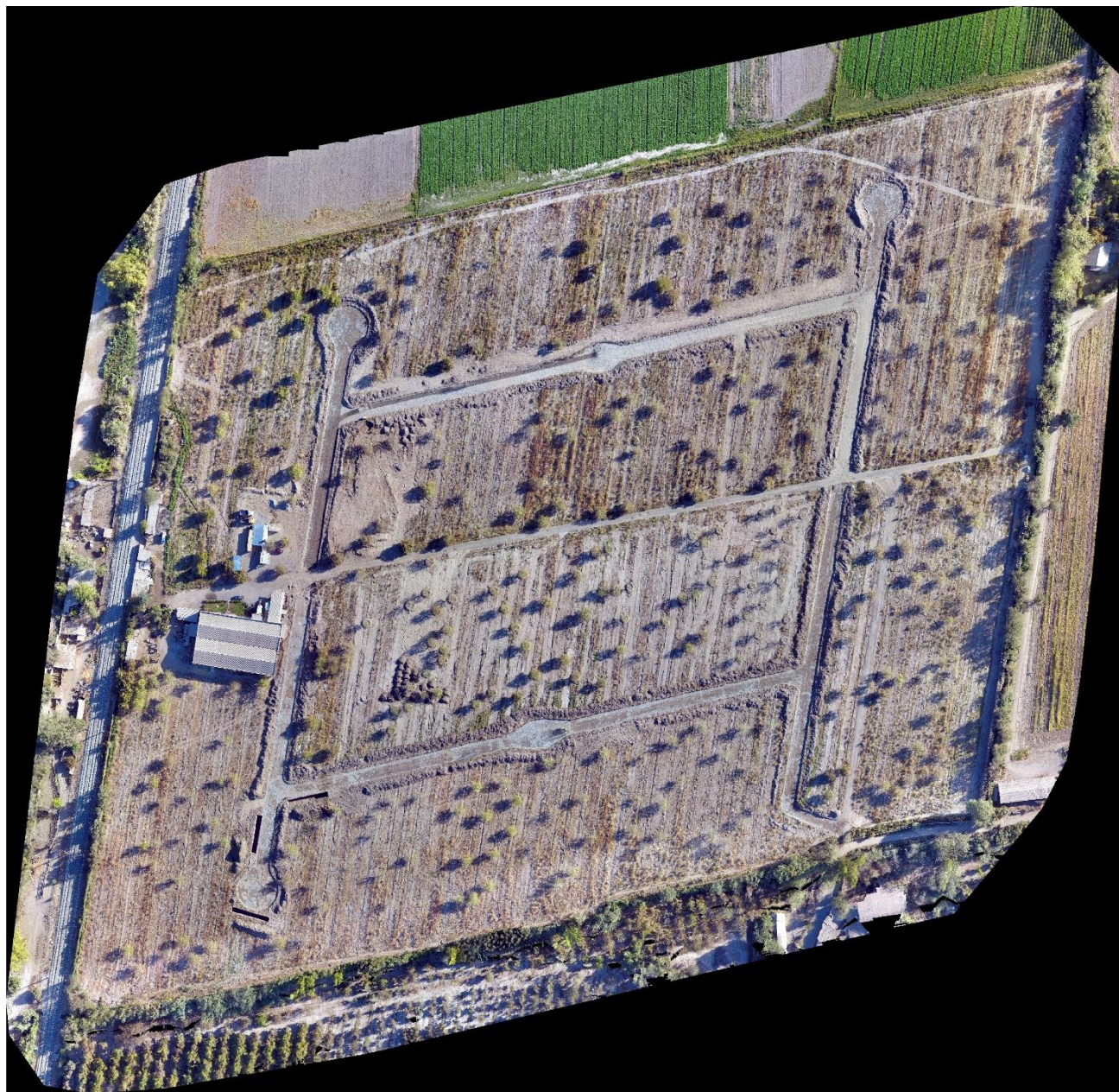
Ortofoto desde Dron. Trazado y excavación para preparación estructural de calles.
