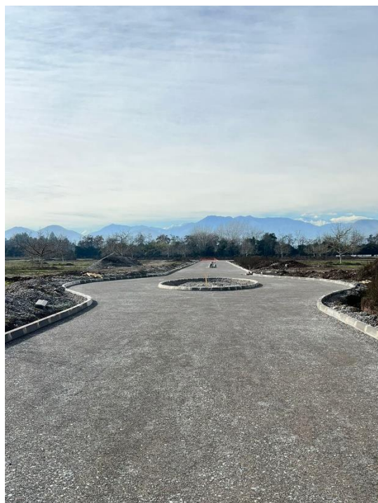
Calle con base compactada lista para la recepción de la carpeta asfáltica.
