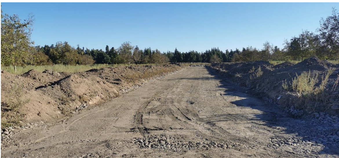
Corte Masivo de Calles 1, 2, 3 y 4.
