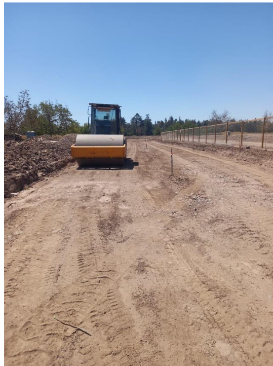
Preparacion de subrasante previo a la colocacion de base estabilizada.
