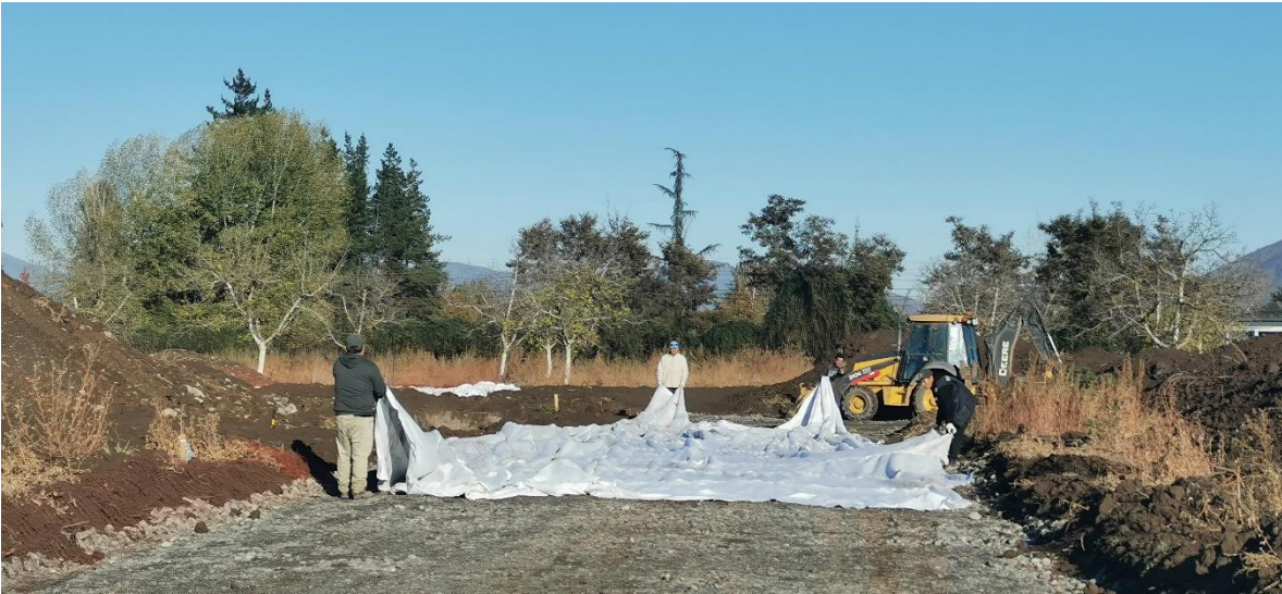
Confección de mantos geotextil feltrex, para recubrimiento de dren y contención de bolones.
