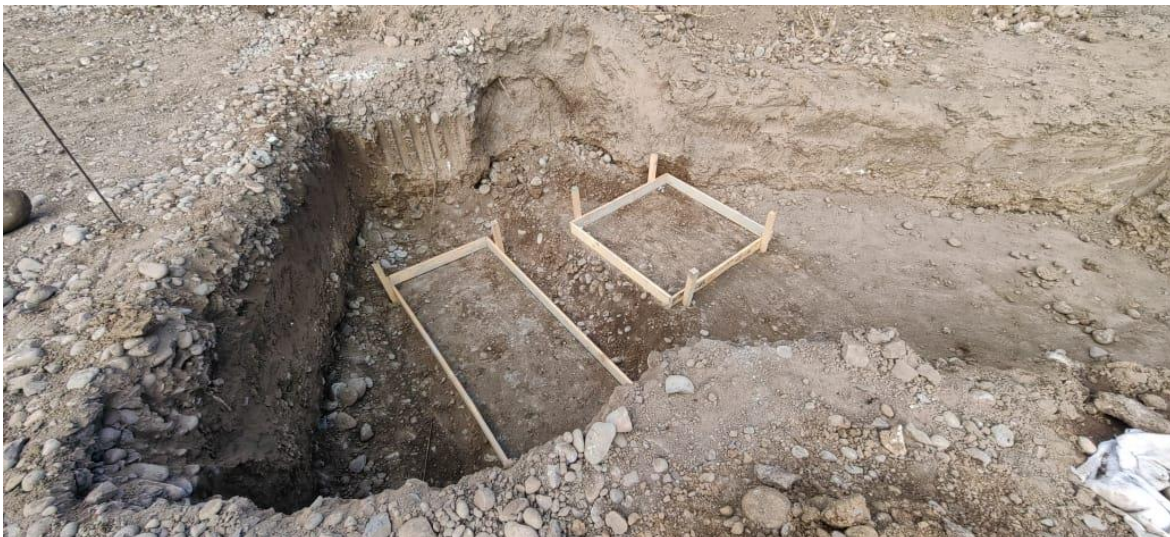
Instalación de moldajes para emplantillados.
