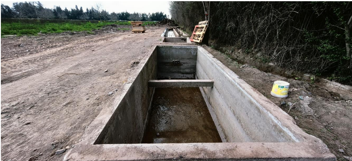
Restauración de decantadores de aguas para riego.
