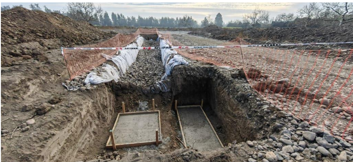
Hormigonado de emplantillados.
